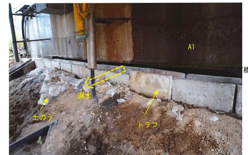
写真-3. A1橋台 漏水対策(土のう積・トラフ)状況 (応急程度)
