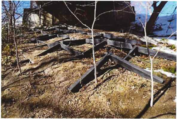
写真-2.1 変状状況(左：A1全景)
