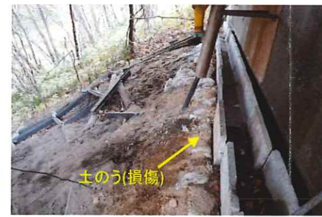
写真-5.7 トラフ下からの漏水・応急措置(土のう)
