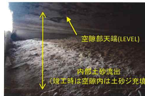
写真-5.6 堅壁空隙部内部(沈下)
