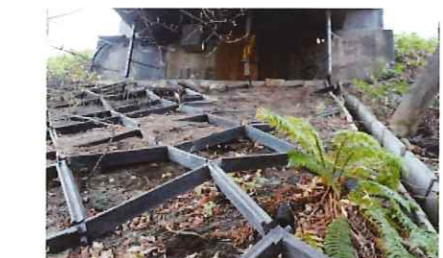
写真-5.3 A1・変状状況(洗掘・凍害)
