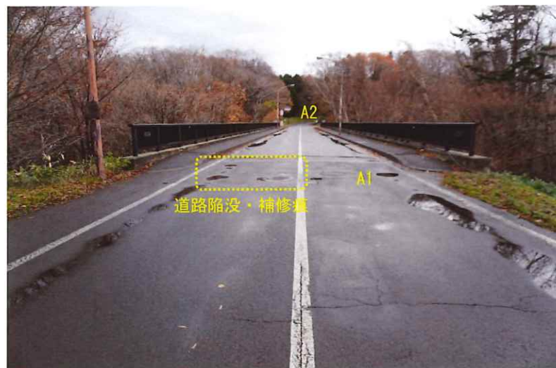
写真-1. 起点から終点を望む(A1橋台背面 陥没・補修済み)
