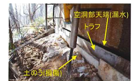
写真-5.5 A1・簡易的なトラフ・土のう設置(袋の消失・土砂流出)による土のう設置
