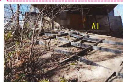
写真-5.1 A1橋台変状(床掘・埋戻し部)
