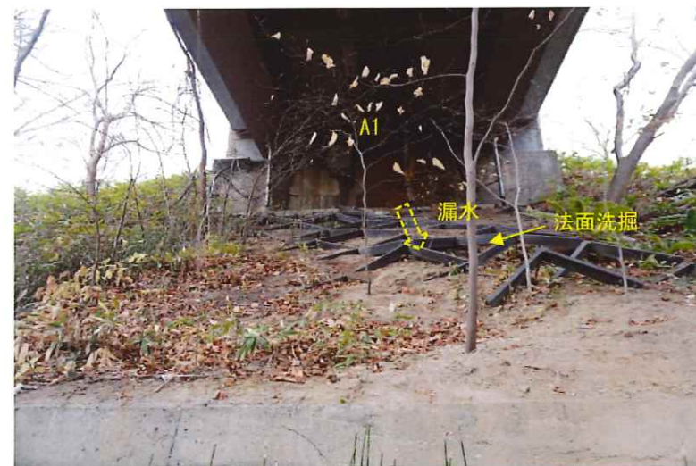
写真-2. A1橋台 保護護岸(法枠ブロック)損傷状況
