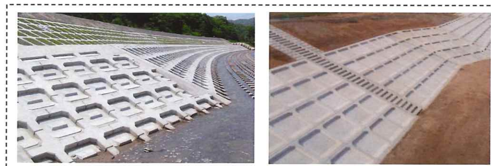
写真-5.8 コンクリート中詰材を使用した法枠ブロック
