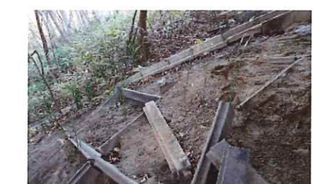
写真-5.4 A1・軽量の法枠ブロック倒壊
