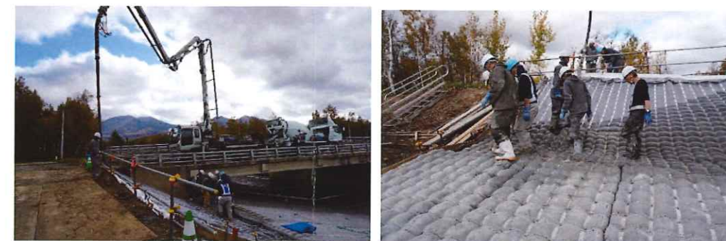
写真-6.2 布製型枠工法施工(イメージ)
