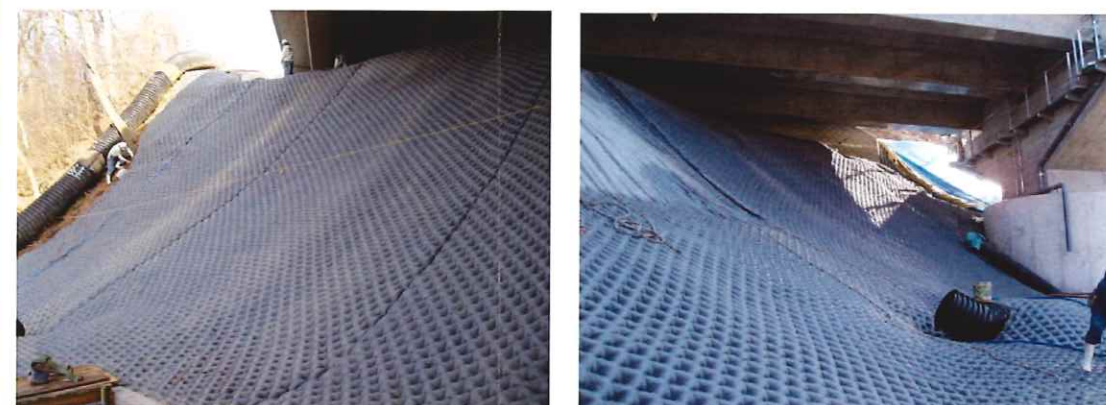
写真-6.1 布製型枠工法(イメージ)
